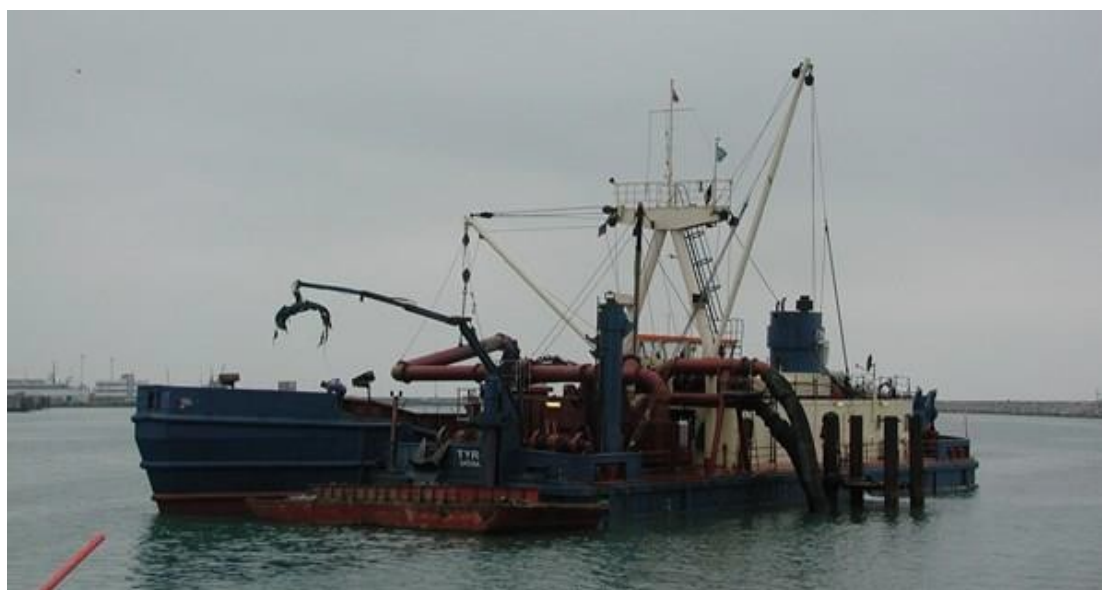
.Tyr R. Pumpestation til tømning af pramme eller transport af materiale. Kan pumpe ca. 4 km. (Foto RN)
